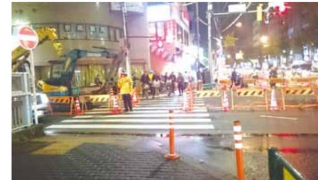
29年度の開通をめざしエレベーター工事は進んでいます。環7の側溝地下6メートルを掘削、現在方南町交差点まで地下坑が40m掘られました。掘削した土砂は地下坑から、エレベーター設置場所に運出す作業が続いています。
